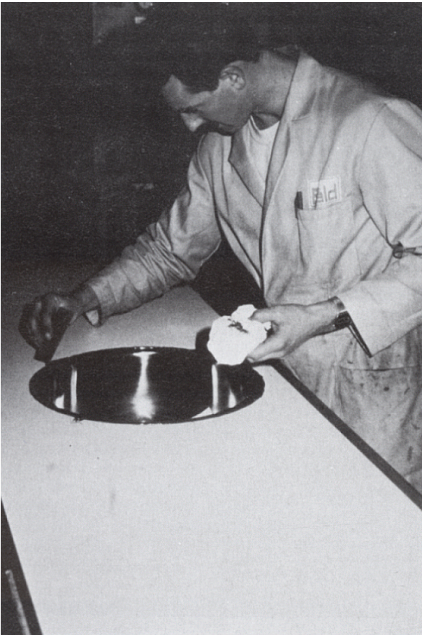
figuur 2.100 Inlijmen van een roestvaststalen wasbak in een met kunststof bekleed aanrechtblok (foto CIBA)
