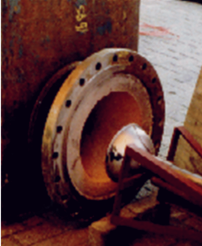
figuur 8.4 Voorwarmen van een lasplaats via infrarood straling
